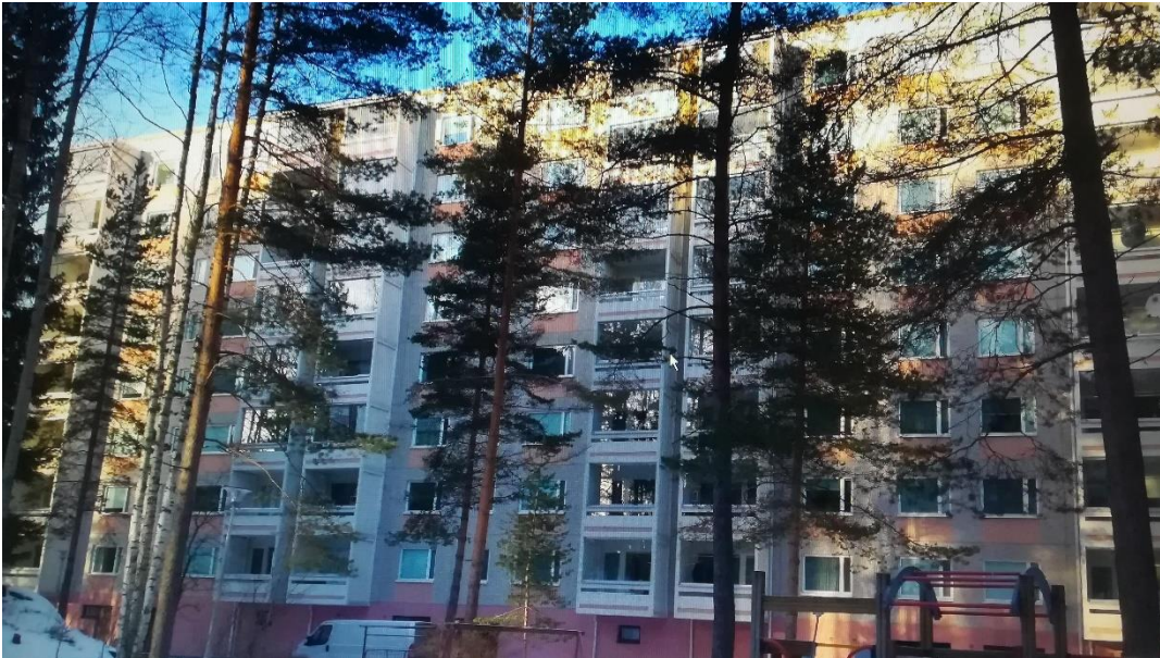
Kuva 1. Parvekkeiden puoleinen julkisivu.
